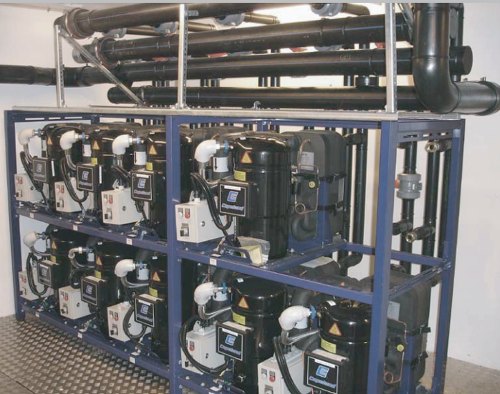
■BLACK BOX 9台モジュール (7台運転+2台予備ユニット)
