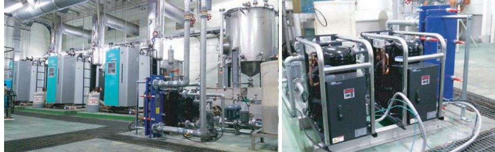
大手食品工場様 大型冷凍機用クーリングタワー熱利用/ボイラー給水加熱 洗浄用温水 2台
