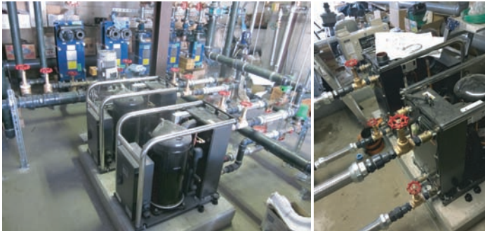
大手食品工場様 大型冷凍機用クーリングタワー熱利用/ボイラー給水加熱 洗浄用温水 2台
