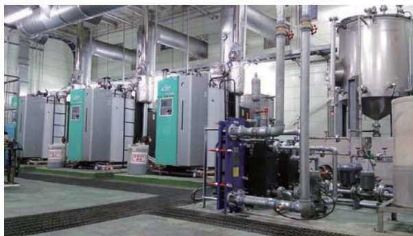
大手食品工場様 大型冷凍機用クーリングタワー熱利用/ボイラー給水加熱 洗浄用温水 10馬力×2台
