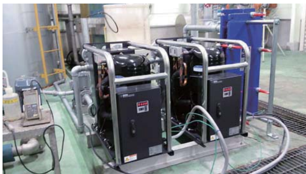
大手食品工場様 大型冷凍機用クーリングタワー熱利用/ボイラー給水加熱 洗浄用温水 10馬力×2台
