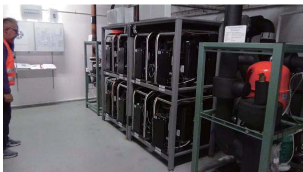
SWEDEN 大手食品冷凍工場様 冷凍用 冷風発生器 10馬力×8台
