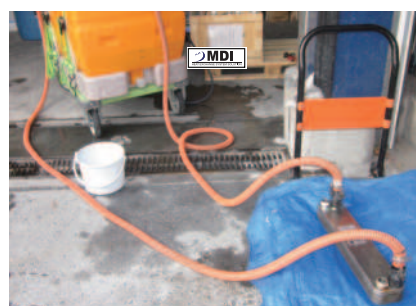
熱交換器の洗浄: 開放洗浄ではなく、循環洗浄で簡単に短時間で汚れが取り除けるかを評価 (MDI 製 CIP 洗浄装置 + 洗浄液ダイナミック GC-S)
